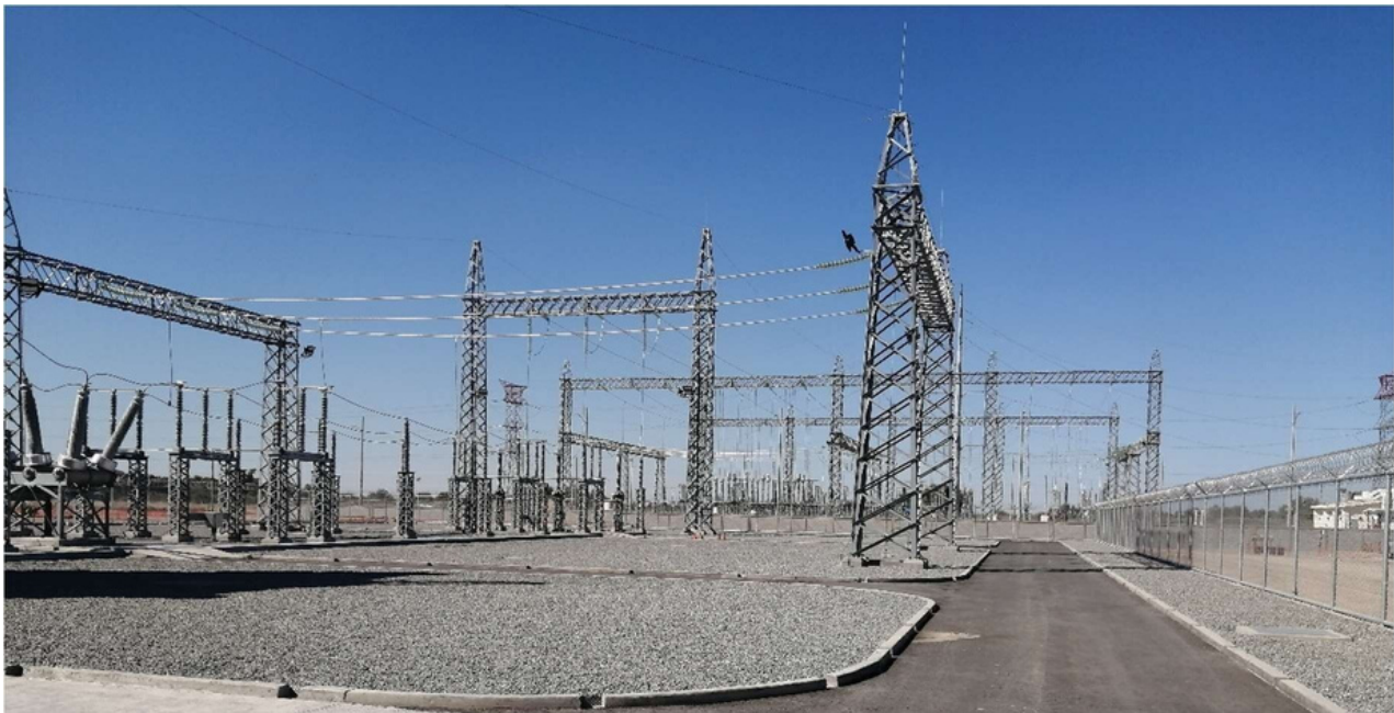
SE CERVEZA, Ubicada en Mexicali Baja California, dentro del Proyecto Constellation Brand.
