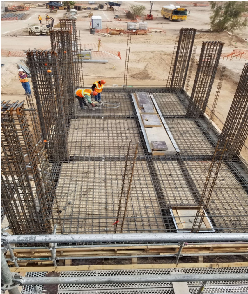
Construcción Losa de entrepiso de metal clad SE CERVEZA.
